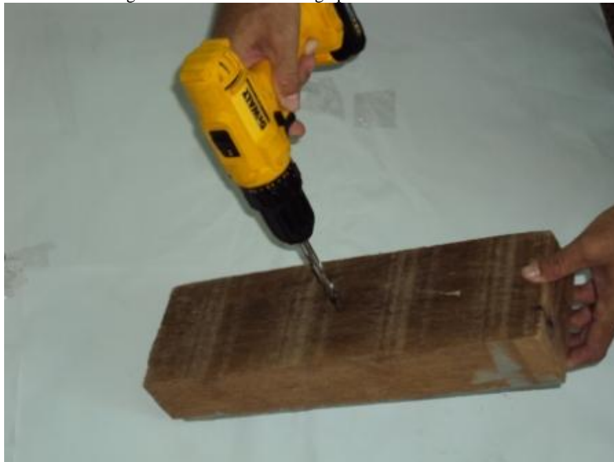
Figura 6.2 - Perfurando a viga para o encaixe da haste.
