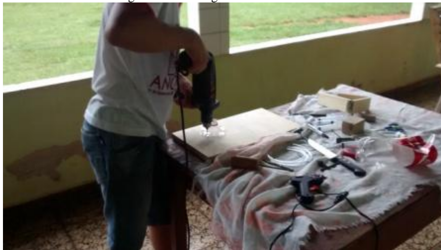
Figura 4.9 - Base giratório sendo fixada.
