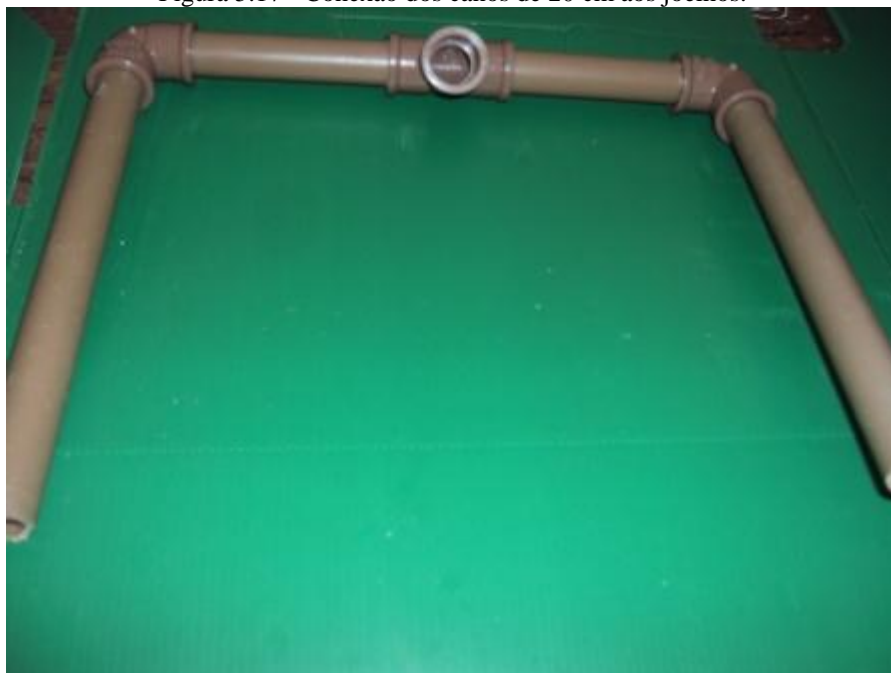
Figura 5.17 - Conexão dos canos de 20 cm aos joelhos.
